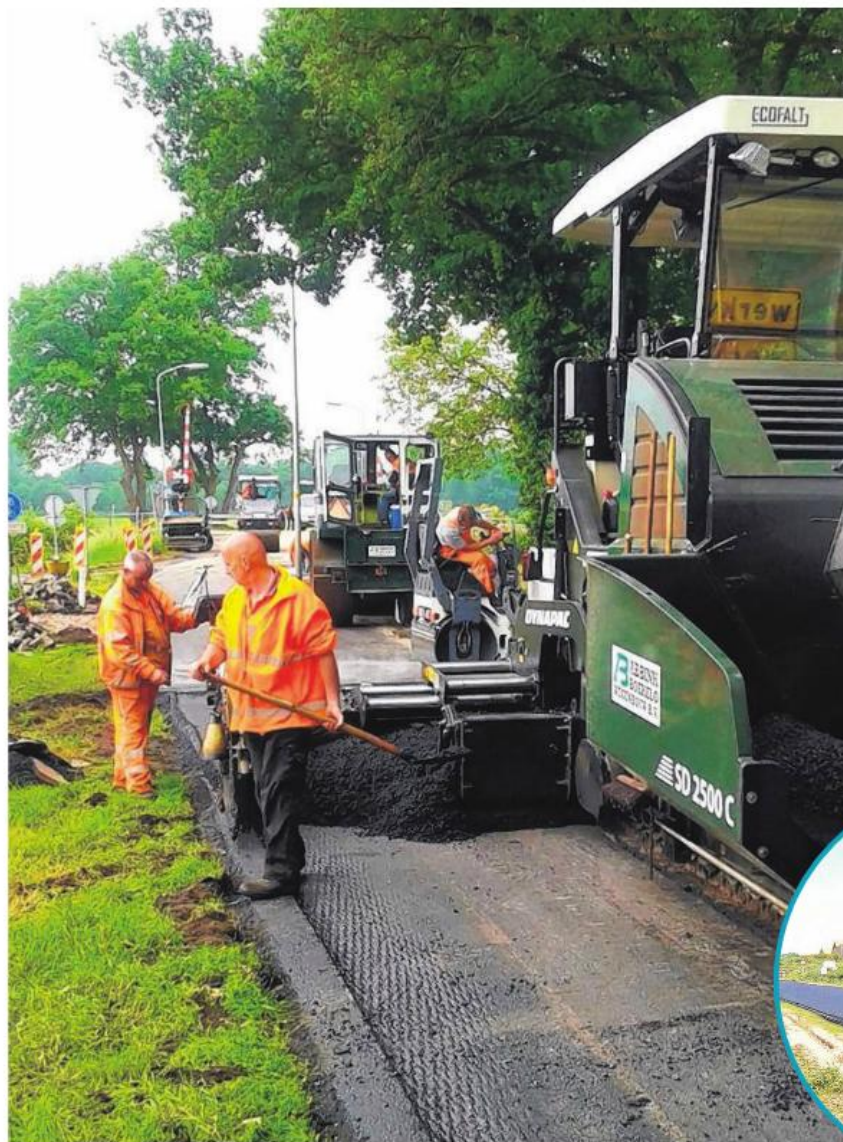
• Abbink asfalteert een weg met Ecofalt op Terschelling. foto's Abbink Boekelo Wegenbouw
